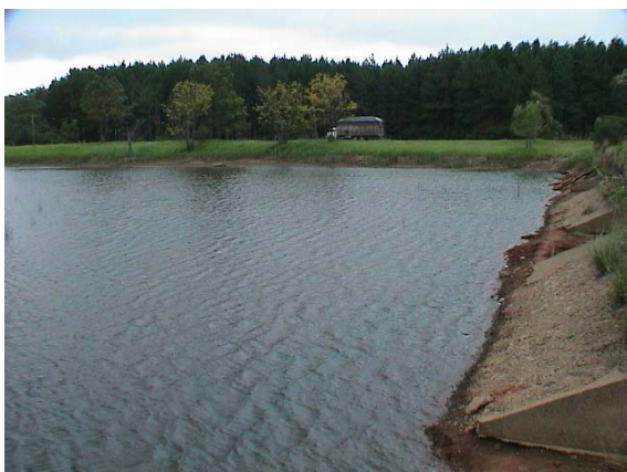
FIGURA 3.76 - LAGO JUNTO À BARRAGEM CUJA BASE ENCONTRA-SE DESESTRUTURADA
